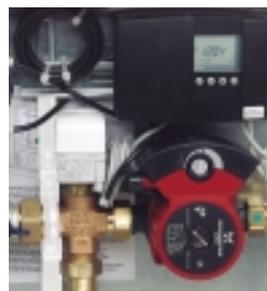
Рис. Блок управления для регулирования температуры воды в подающей трубе в зависимости от температуры наружного воздуха с энергосберегающим циркуляционным насосом со встроенным электронным устройством согласования мощности.
